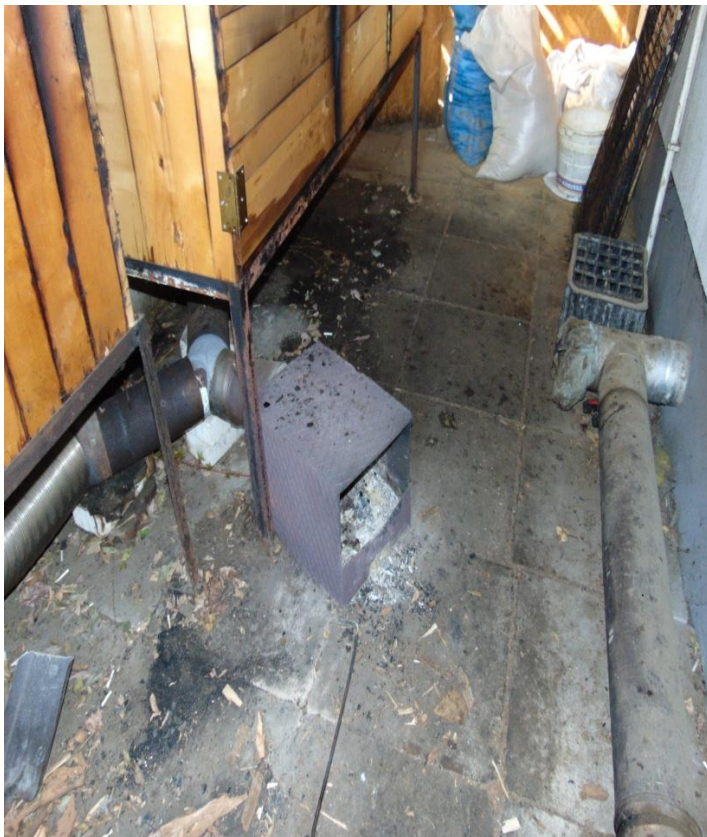
Rys. 14. Palenisko komory wędzarniczej
