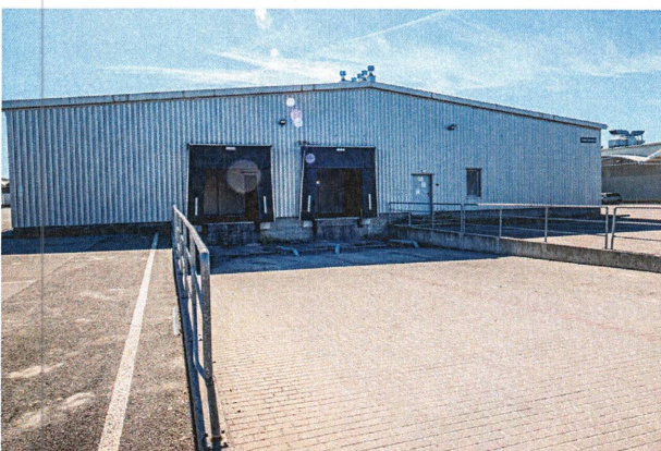
2 bramy z dokami rozładunkowymi
